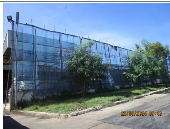
ภาพที่ 2.1-8 : ผ้าใบกันฝุ่นละอองบริเวณพื้นที่ หน้าท่าเทียบเรือ
