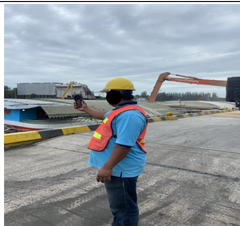
ภาพที่ 2.1-10 : ผู้ปฏิบัติงานหน้าท่าใช้เครื่องวัด ความเร็วลมขณะขนถ่ายสินค้า
